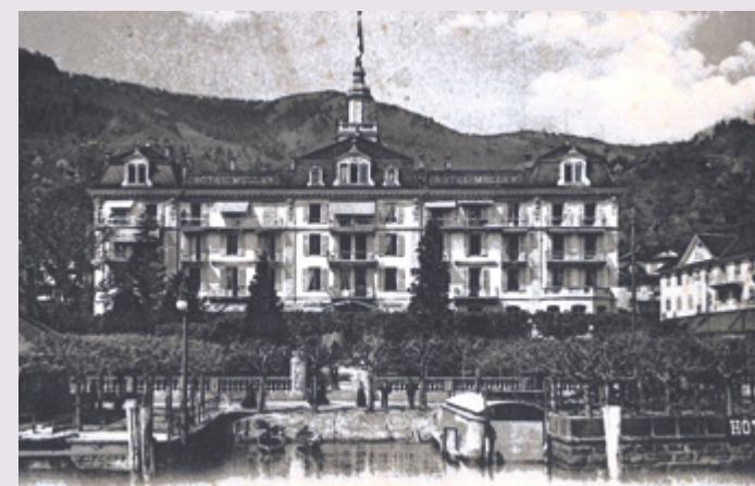
Hauptfassade nach Umbau von 1891, Ansichtskarte ca. 1903
