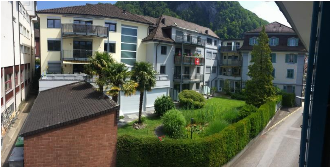
Anbauten Tschalungasse 1 und 1A, Garten und Verbindungstrakt zum „Haus zum Hof“ Dorfstrasse 18, Eigentums- und Mietwohnungen
