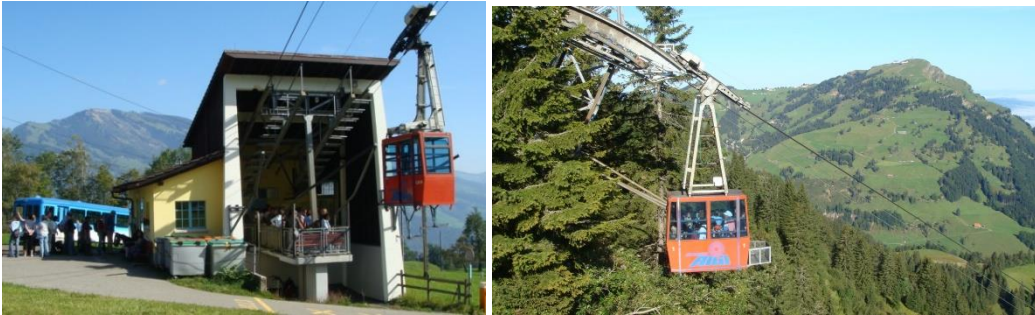
Talstation Kräbel, Luftseilbahn Kräbel – Rigi-Scheidegg
