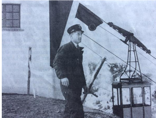
Tschany Baggenstos, Mann für alle Fälle und Arbeiten.
