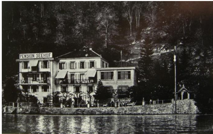
Pension Seehof mit neuem Anbau Ost
